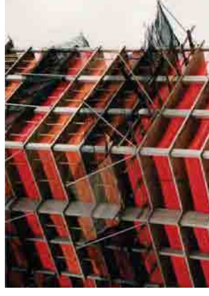
تصاویر ۶-۸: نمای از اجرای تهرهای ایمنی (سلایت در بستر)
